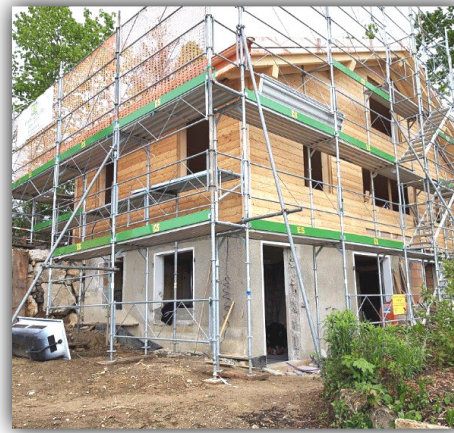
Préfabrication en atelier à Saxon, 1 jour de pose, cours de travaux et vue depuis le nord-ouest
